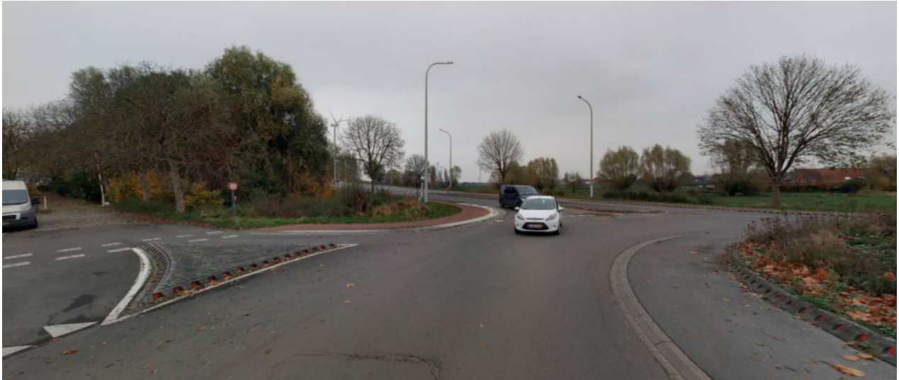
Figuur 72: Verkeerseilanden op een rondpunt langs de rotonde aan de brug naar Kachtem, links in tegels en rechts in asfalt aangelegd (Cyclosmart).
