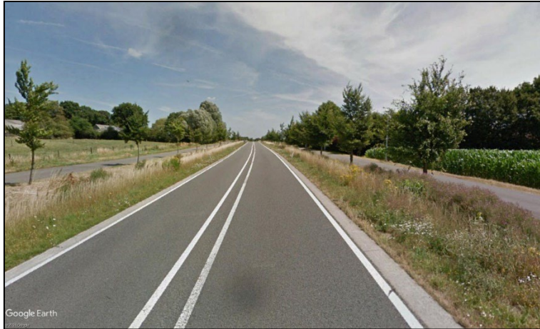
Figuur 80: Uitgevoerde infiltratieberm, links en rechts, langs de R34 (Google Earth, sd).
