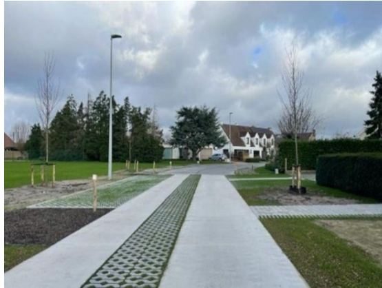
Figuur 92: Voorbeeld van hoe een infiltratieberm in een straat kan worden toegepast, hier in Oostkamp (Google Earth, sd).
