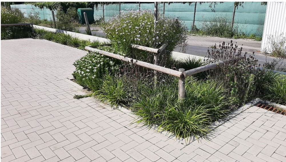
Figuur 94: Voorbeeld waar de straat en parkeerplaatsen kunnen afwateren in een met planten bezet perkje.
