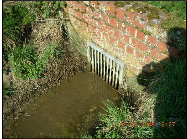
Figuur 60: Voorbeeld van inlaat, Aansluiting van 2 langsgrachten van de Molstraat (VMM, Rioolinventaris, 2021)
