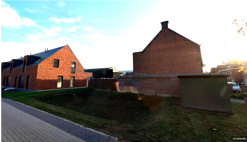
Figuur 35: Bufferbekken nabij een nieuwe verkaveling. Hier aangelegd om als verkaveling te voldoen aan het GSVH.
